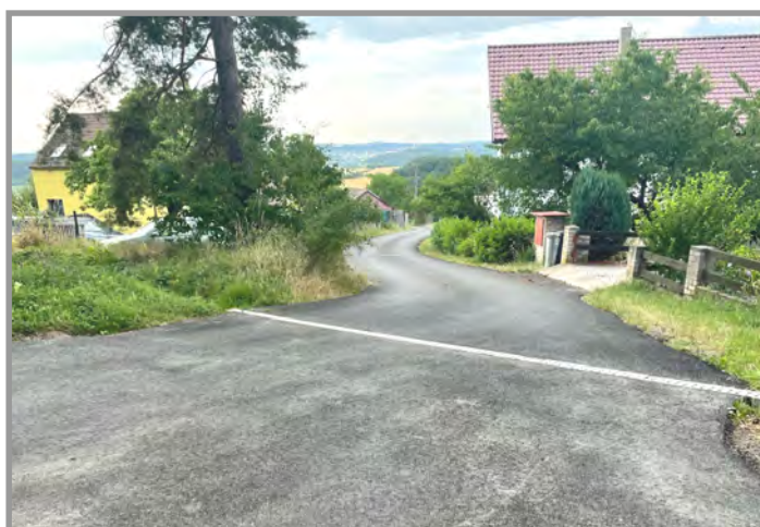
Oprava místní komunikace u č. p. 231–185
